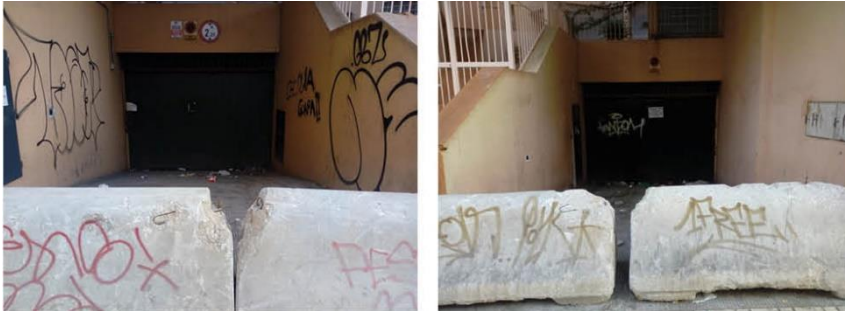
Fig.2.19: Bajos de dos edificios de Cruz Verde con aparcamientos actualmente clausurados.
