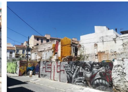
Fig. 5.5 Solar en C/Cobertizo del Conde
