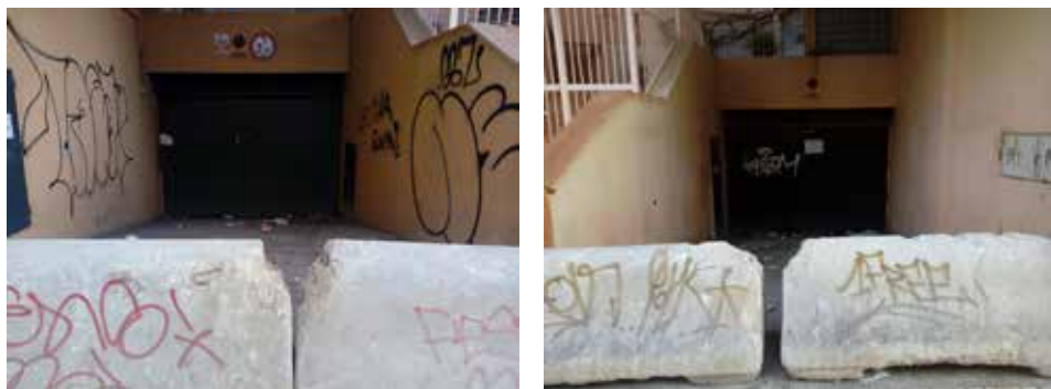
Figura 50. Bajos de dos edificios de Cruz Verde con aparcamientos actualmente clausurados. Fotografías cedidas por una vecina de Lagunillas al grupo Motor
